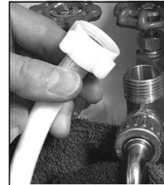
Desconecte, revise y reconecte la manguera de drenaje
