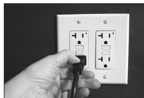
Verifique que el enchufe funciona con otro dispositivo y que el cable eléctrico funciona en otro enchufe
